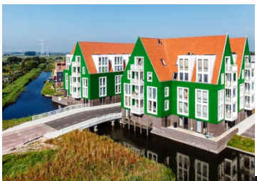
Lujendijk, Landsmeer 2015 nieuwbouw appartementen en woningen
