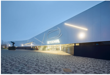
Elfstedehal Leeuwarden 2015 nieuwbouw stadsijsbaan met GEAR
